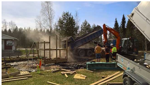
Leikkipuiston rakennusta toukokuussa.
