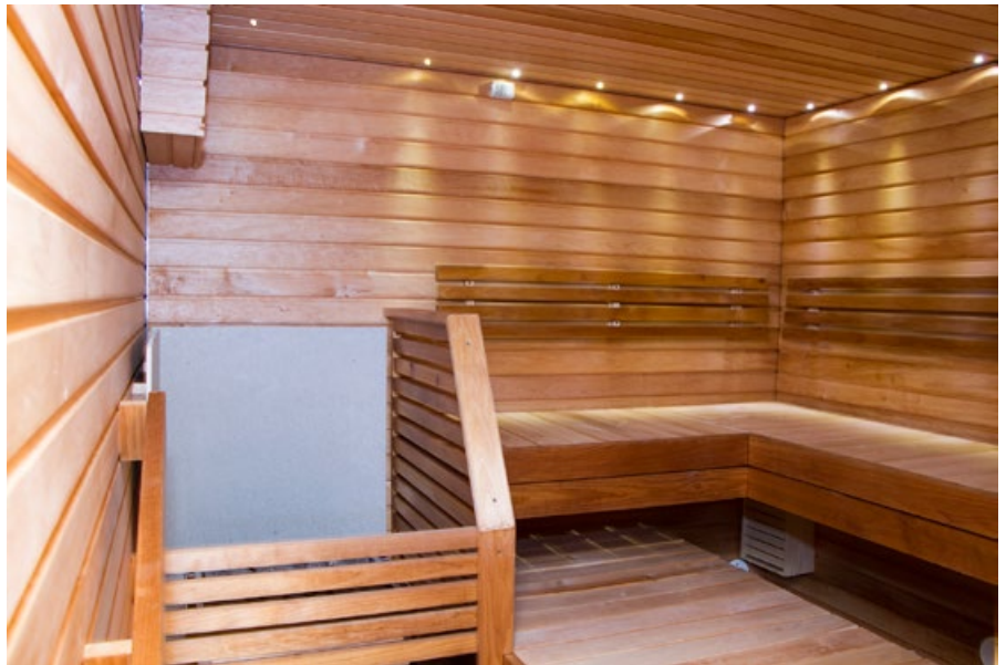
Lauteet rakennettiin tervalepystä ja lämpökäsitellystä haapa-puusta.
